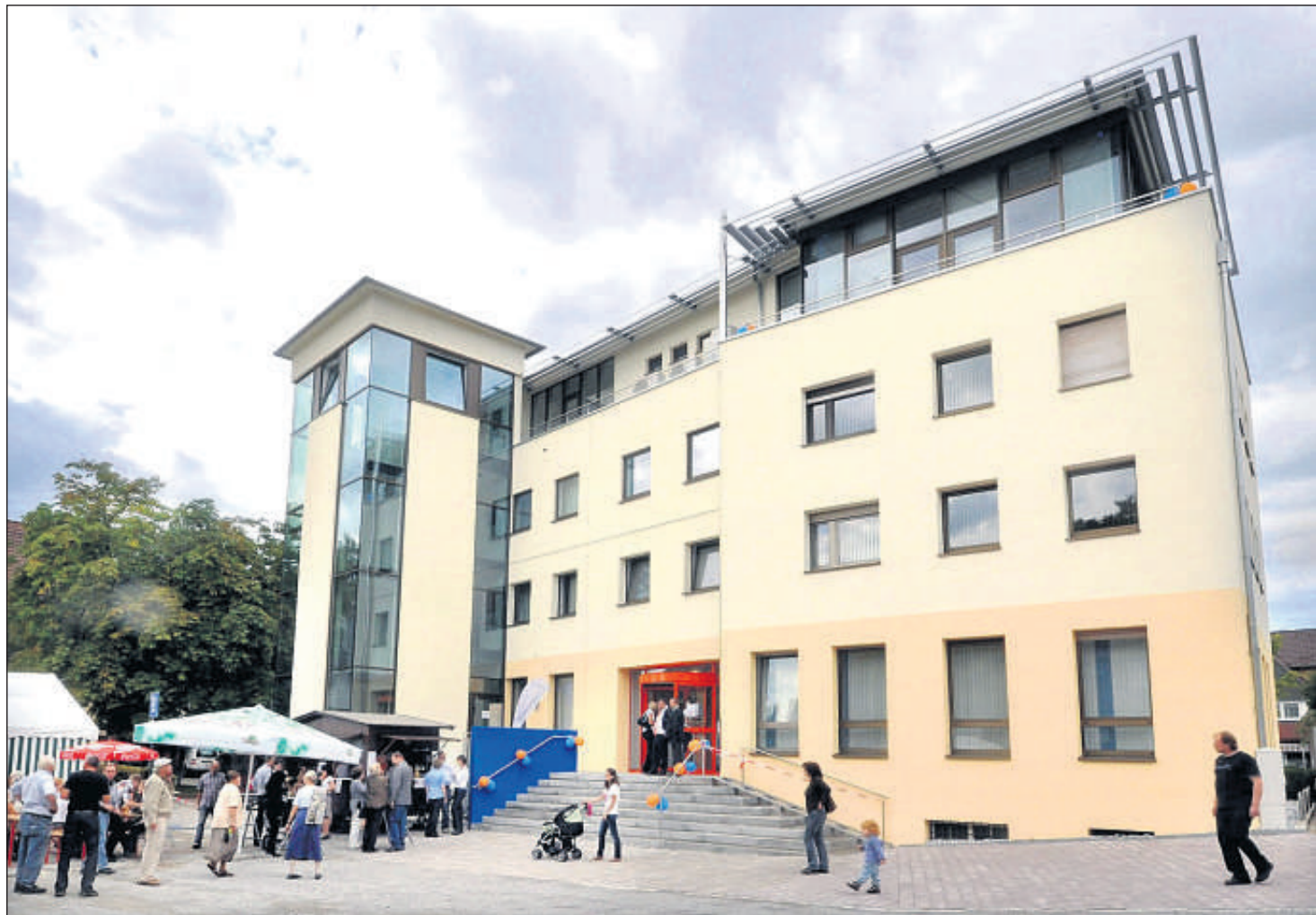
Umbau und Erweiterung der Welzheimer Volksbank wurden mit einem Tag der offenen Tür gefeiert. Das oberste Stockwerk ist ganz neu.
